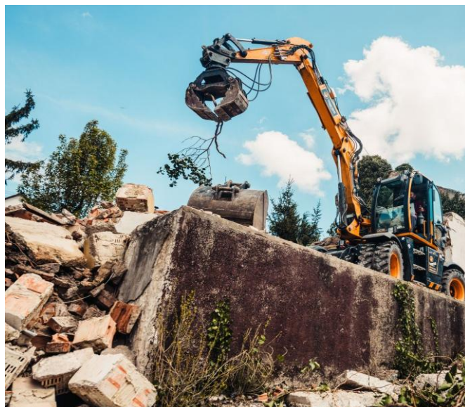
Phá dỡ kết cấu bê tông, tường móng sát công trình liền kề bằng máy bán kính quay ngắn
