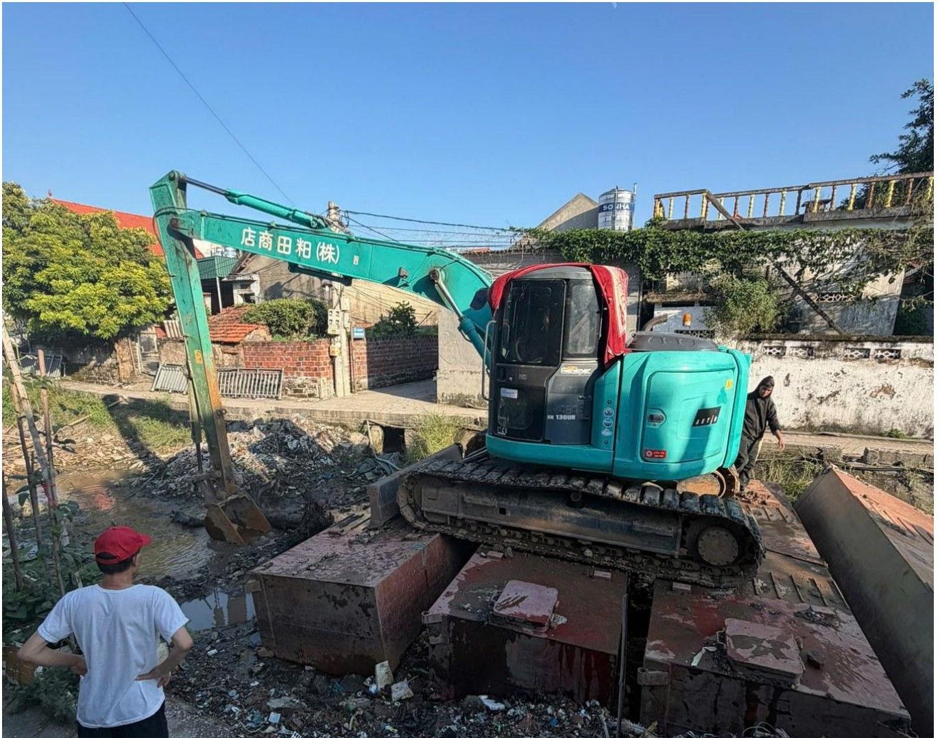
Máy đào Kobelco 130UR trên hệ phao thép nạo vét kênh tiêu, vớt bèo rác trong khu dân cư phường Phong Cốc
