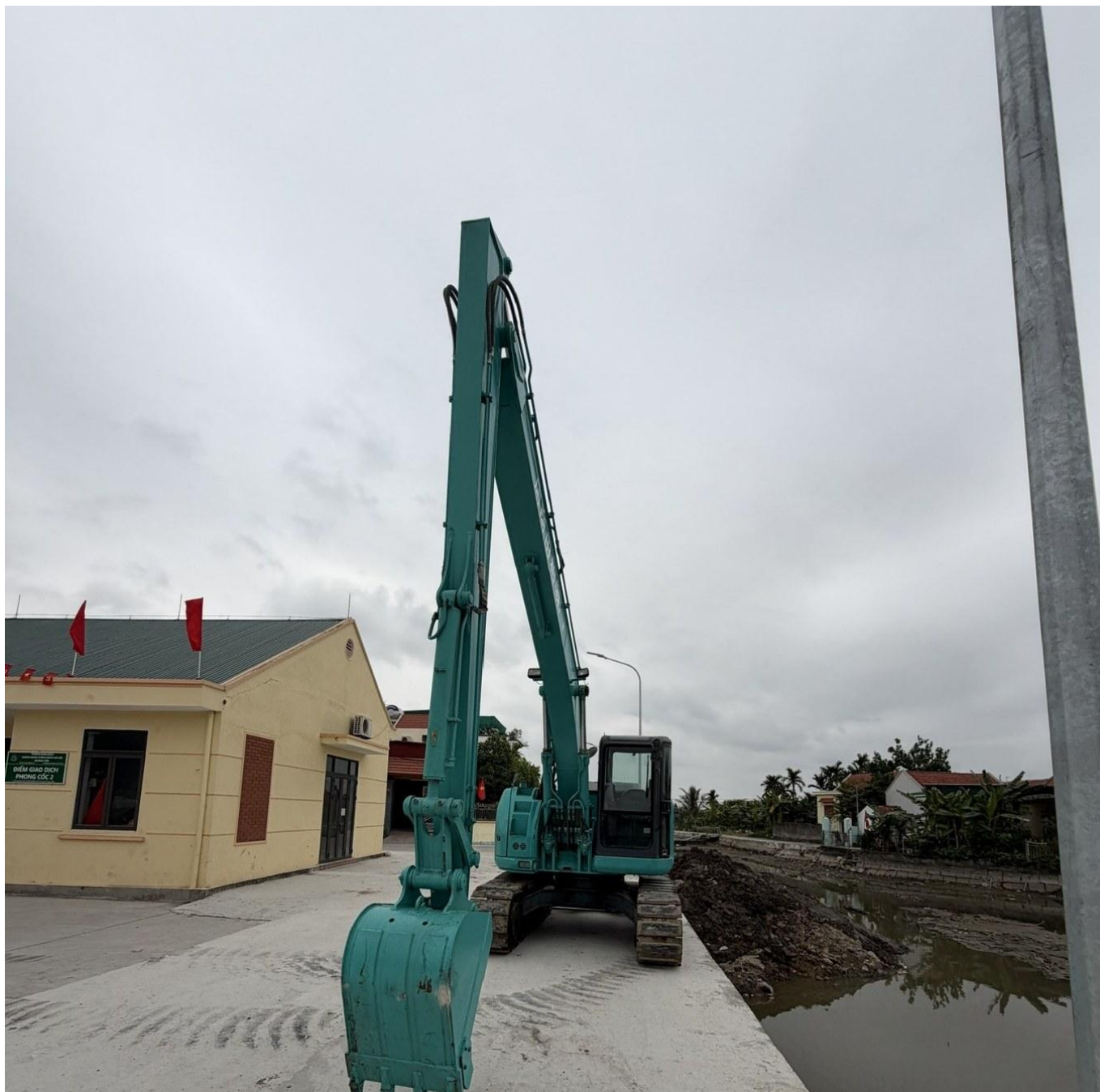
Máy đào Kobelco SK130UR-2 đào đắp, san gạt bờ kênh và mặt bằng tại khu vực điểm giao dịch Phong Cốc 2
