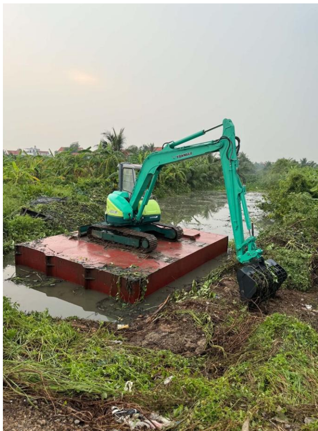
Máy đào mini Yanmar trên phao nổi – nạo vét kênh nội đồng
