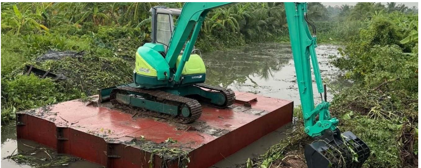
Máy đào mini Yanmar trên phao nổi nạo vét kênh nội đồng, khơi thông dòng chảy phục vụ sản xuất nông nghiệp
