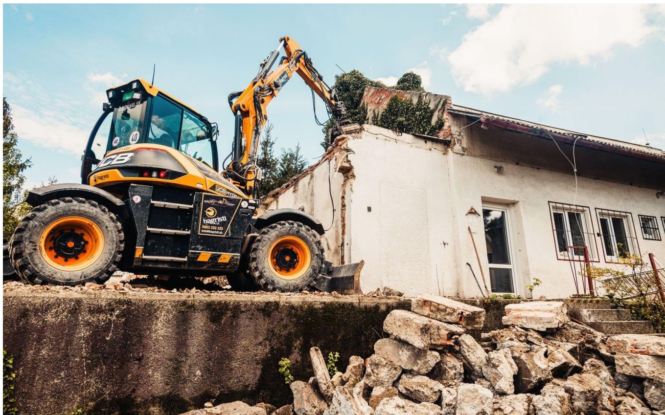
Phá dỡ nhà cũ, nhà xưởng bằng máy đào gắn gầu, búa đập; thi công có che chắn, tưới nước giảm bụi
