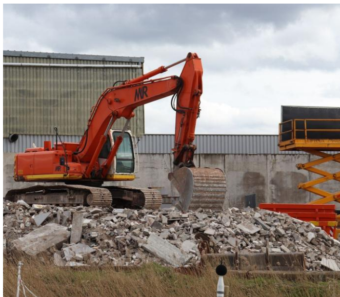
Bốc xúc, phân loại phế thải xây dựng lên xe tải đưa đi đổ đúng nơi quy định
