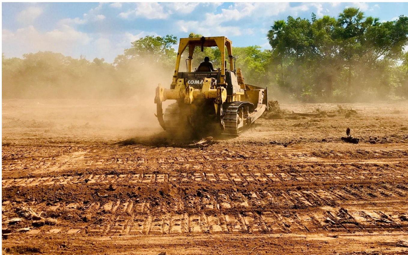
Máy ủi san gạt, đắp nền từng lớp theo cao độ thiết kế trước khi lu lèn mặt bằng nhà xưởng
