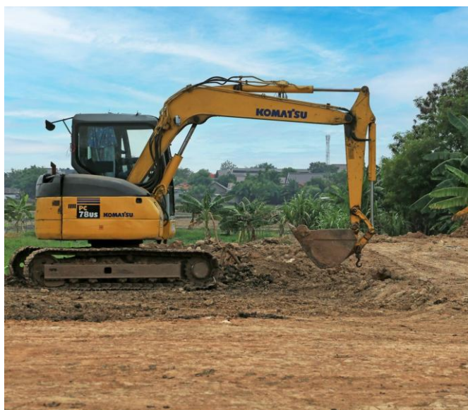
Máy đào đào móng, bóc hữu cơ và đào đắp mặt bằng khu dân cư
